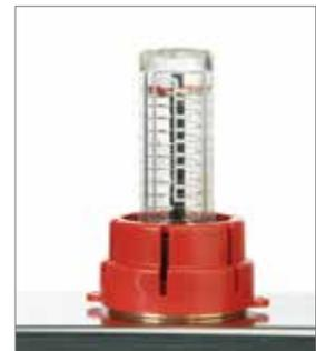
Im Vorlaufbalken ist für jede Heizgruppe ein Durchflussmengenmesser integriert. Die Durchflussmengenmesser lassen sich von 0-5 l/min einstellen und ermöglichen den idealen hydraulischen Abgleich der Heizkreise untereinander.
