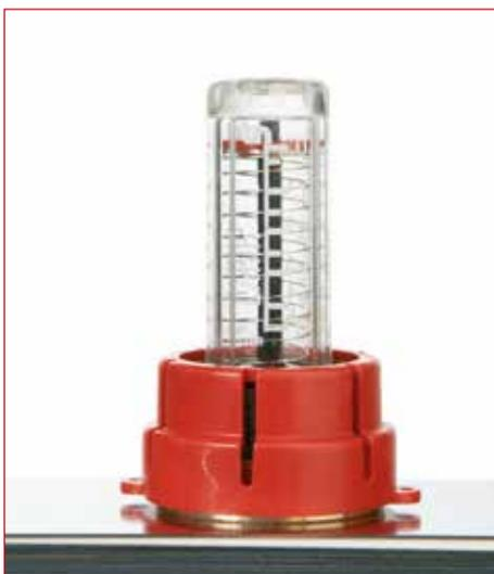
Im Vorlaufbalken ist für jede Heizgruppe ein Durchflussmengenmesser integriert. Die Durchflussmengenmesser lassen sich von 0-2,5 l/min einstellen und ermöglichen den idealen hydraulischen Abgleich der Heizkreise untereinander.
